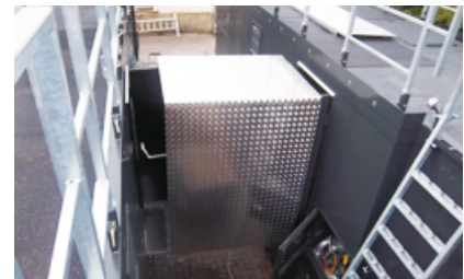
Verbindungstunnel zwischen Trailern
