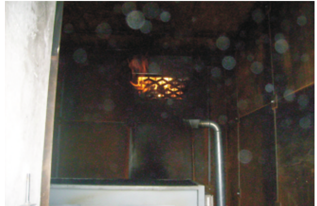
Feu de hotte (commencer)
