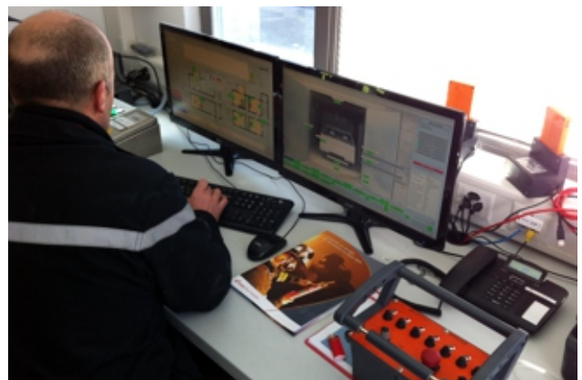
Salle de contrôle
