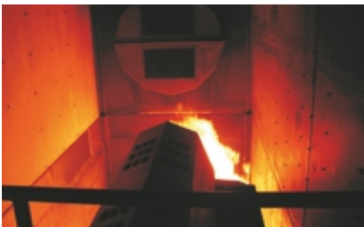
Feux de moteurs et chaudière
